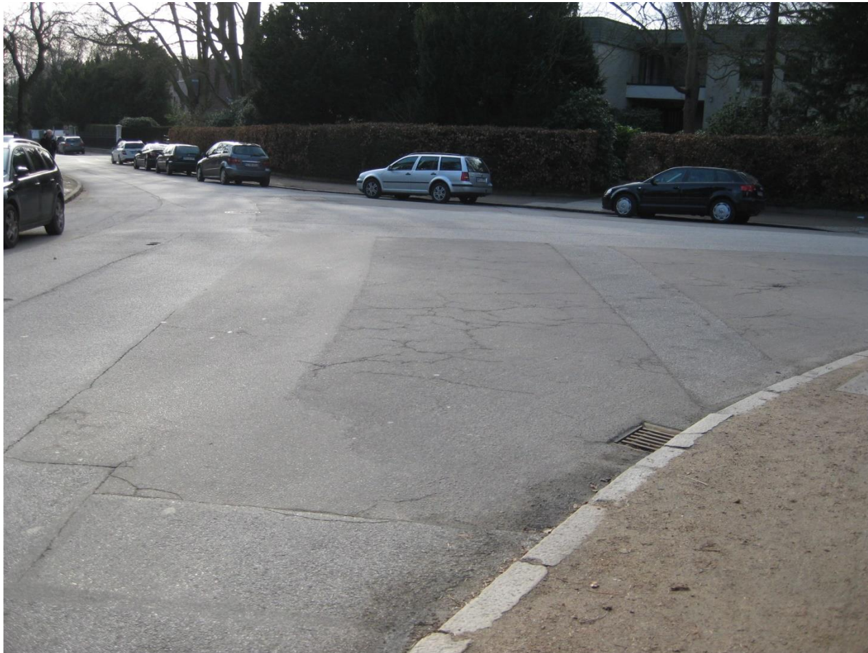
Einmündung Charlotte-Niese-Str. / Jürgensallee
